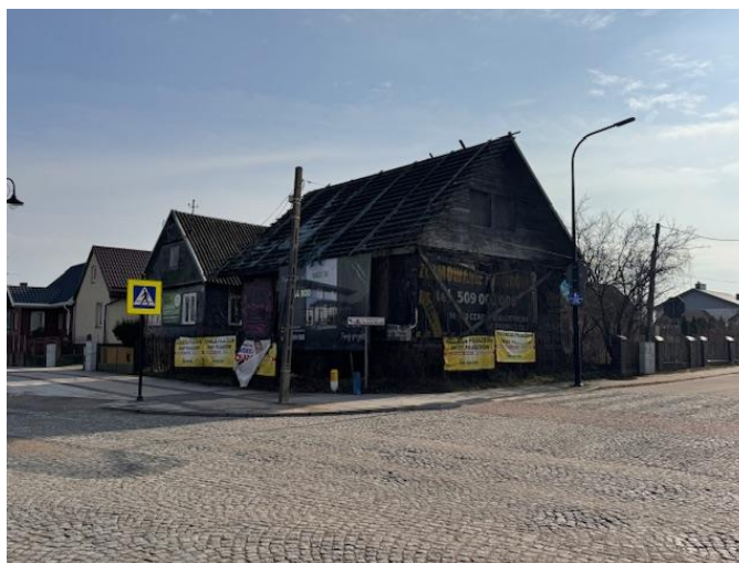
Rysunek 23. Brak ładu przestrzennego i zdegradowanego obiektu mieszkalnego (pustostan).
